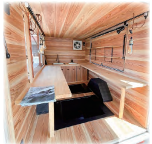
▲ 施工途中のサウナ
