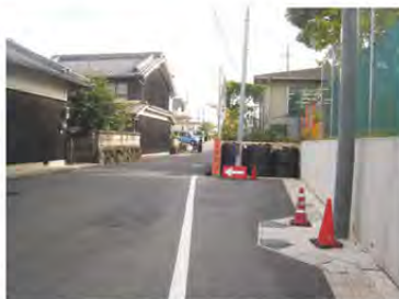
▲赤部26号線西小学校東側拡幅工事
