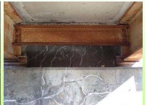
橋台の損傷（ひびわれ）
