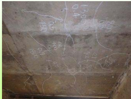
主桁の損傷（ひびわれ）
